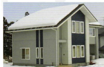
雪の落下防止機能を備えた屋根材 （札幌市 雪止金具等の設置基準同等工法屋根材）
