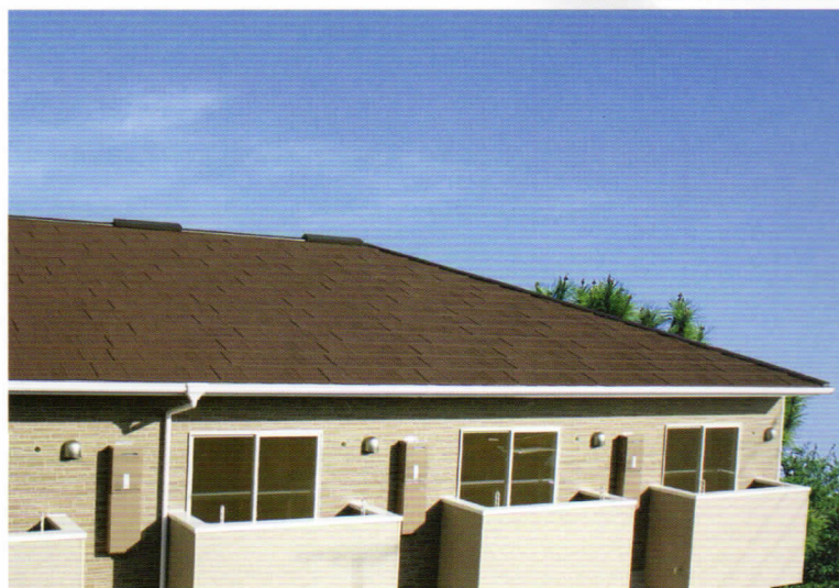
カフェ施工例（GL鋼板役物仕様）
