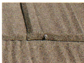
耐風性能 （正面ビス留付工法により優れた耐風性能）
