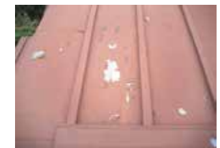
金属立て葺き （既存屋根に構造用合板施工です）
